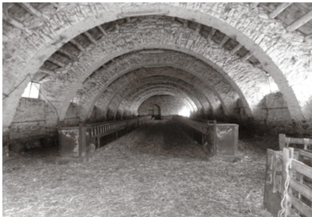
▲ Als Gemeinschaftswerk in traditioneller Gewölbebauweise errichtet: der Schafstall von La Blaquière, die imposante Demo aus Stein.
